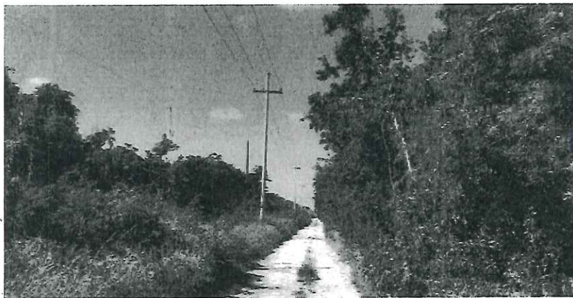
Figura II.5. Vista con dirección Norte del predio donde se observan los postes del tendido eléctrico pertenecientes a la CFE.
