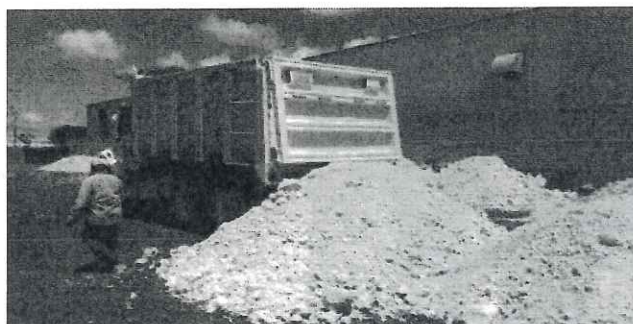
Imagen II.15. Ingreso de volquete con sascab con el fin de esparcir el material que servirá para conformar las áreas de estacionamientos y circulación interna.
