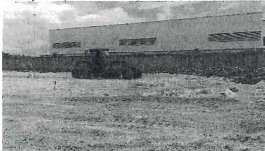
Imagen II.16. Ingreso de volquete con sascab con el fin de esparcir el material que servirá para conformar las áreas de estacionamientos y circulación interna.
