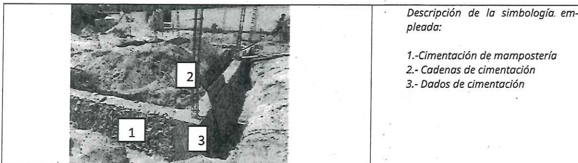
Imagen II.14. Ejemplo de trabajos de cimentación para la construcción de la obra civil de la concretera.
