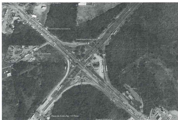
Imagen 3. Vista del sitio del Proyecto sin intervención, imagen de fecha veintisiete de febrero de dos mil veinticuatro, obtenida a través de Google Earth .
