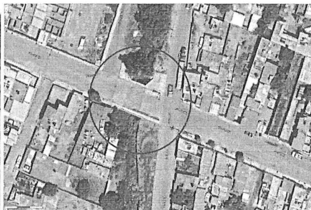
Imagen 4.- Imagen del doce de abril de dos mil veinticuatro tomada de Google Earth en la que se observa el área del Proyecto con obras ejecutadas.
