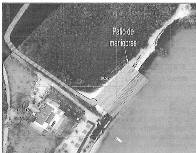
Imagen 1. Zona destinada al patio de maniobras y la zona de embarque, proporcionada por el Promovente .
