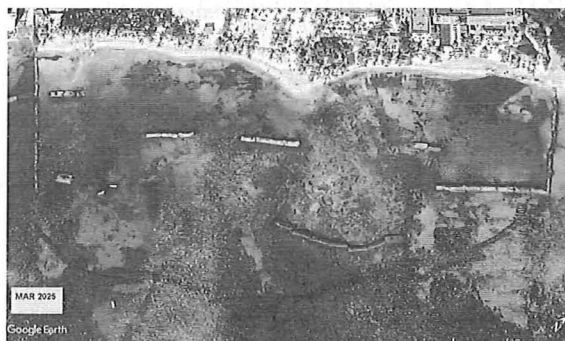
Imagen 11. Vista satelital de la ubicación del Proyecto "Cortina antidispersión", en la que se observa la construcción de rompeolas. (marzo 2025).
