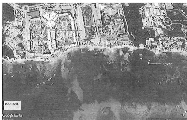
Imagen 9. Vista satelital de la ubicación del Proyecto "rompeolas", en la que se observa la construcción de rompeolas. (marzo 2025).
