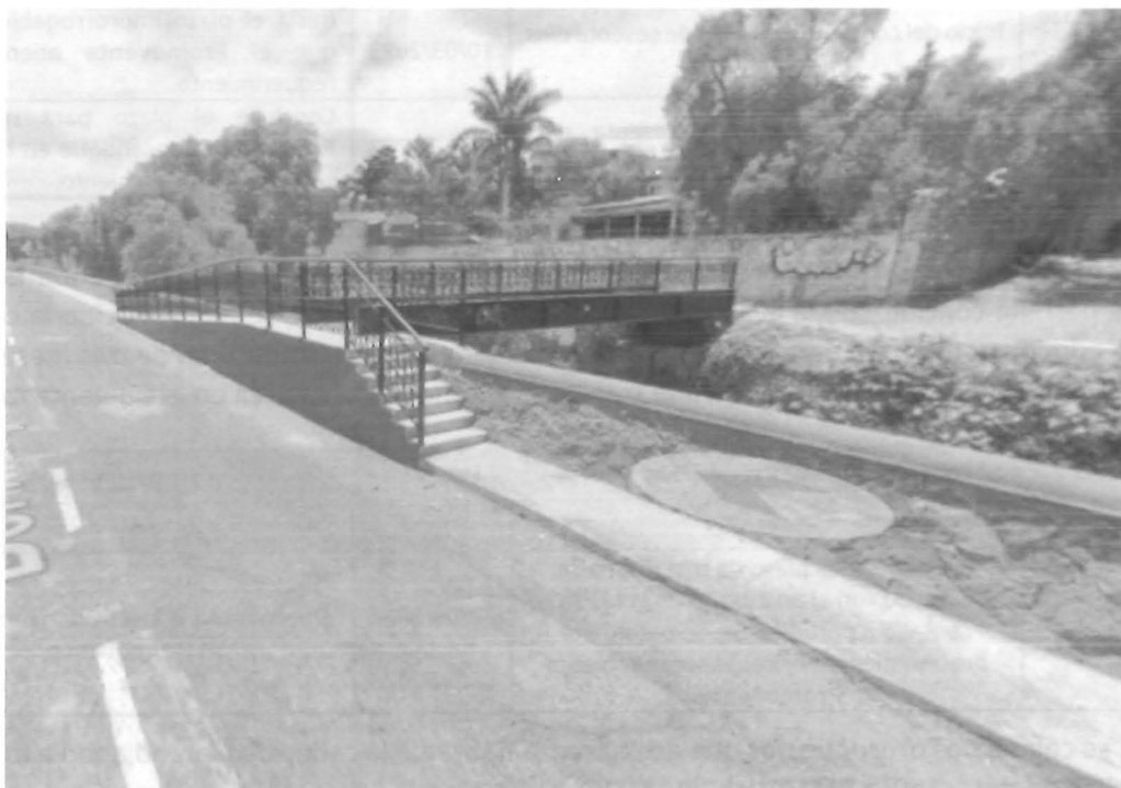
Imagen 1. Obras y/o actividades del Proyecto que se realizaron ( Google Street View , mayo 2024).
