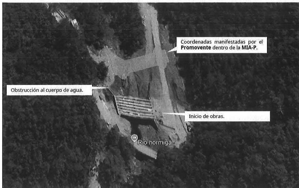
Imagen 4. Obras y actividades realizadas en la zona de intervención del Proyecto (4 de mayo de 2024).
