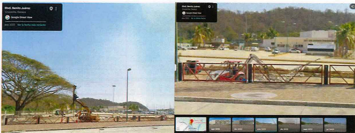
Imágenes 4 y 5. Se observa el inicio de las obras y actividades de demolición de firme (actividades consideradas dentro de la preparación del sitio del Proyecto). Tomada de Google Street View de enero de 2022.
