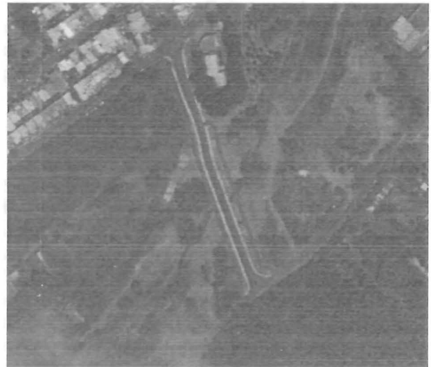
Imagen 3. Se observa el Proyecto construido. Tomada de Google Maps de agosto de 2015.
