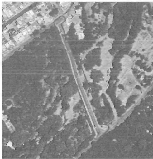
Imagen 4. Se observa el Proyecto construido y en operación. Tomada de Google Maps de agosto de 2025.
