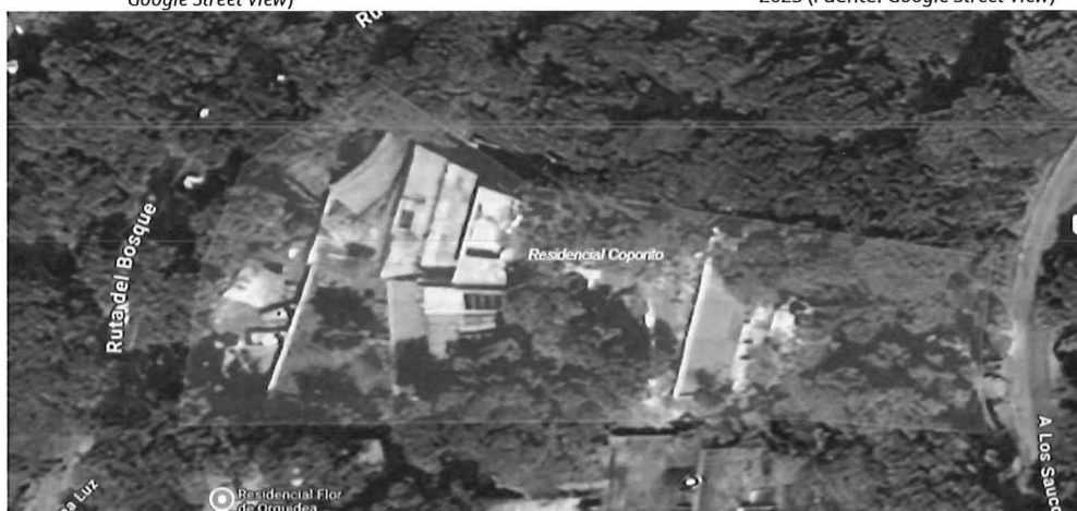
Imagen 3. Se observa la posible conclusión de la construcción del conjunto habitacional, septiembre de 2025 (Fuente: Google Street View y SIGEIA).
