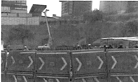
Imagen 3. Se observa maquinaria y trabajadores en el área del Proyecto en el Río San Joaquín. Tomada de Google Maps de enero del 2019, previo al ingreso de Información Adicional .
