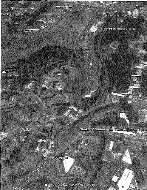
Imagen 1. Se observa el área del proyecto sin la construcción autorizada de la Resolución Administrativa 1 . Tomada de Google Earth , enero del 2016.
