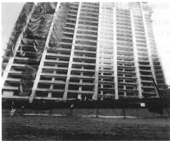
Imagen 2. Obras y actividades del Proyecto de acuerdo con el acta de Inspección PFPA/008/23 .
