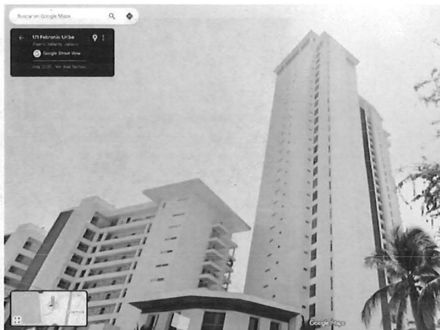
Imagen 6. Obras y actividades del Proyecto finalizadas. Tomada de Google Earth de mayo de 2025.
