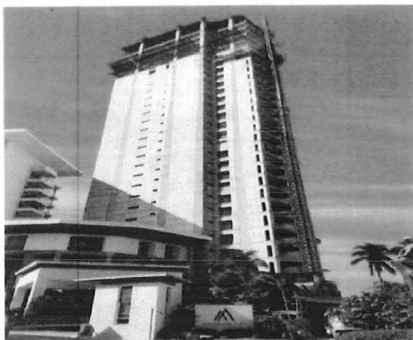
Imagen 5. Obras y actividades del Proyecto de acuerdo con el acta de Inspección PFPA/008/23.
