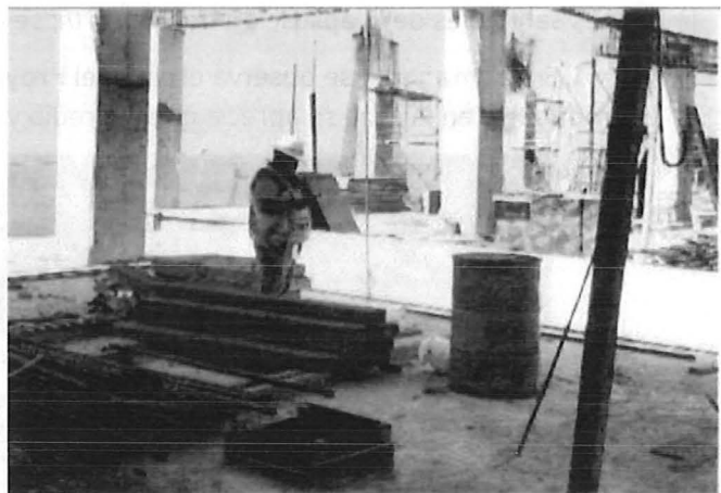
Imagen 3. Obras y actividades del piso 28 (veintiocho) del Proyecto de acuerdo con el acta de Inspección PFPA/008/23 .
