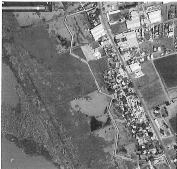
Imagen 5. Se observa la construcción parcial del malecón del Proyecto. Tomada de Google Maps de febrero de 2020.
