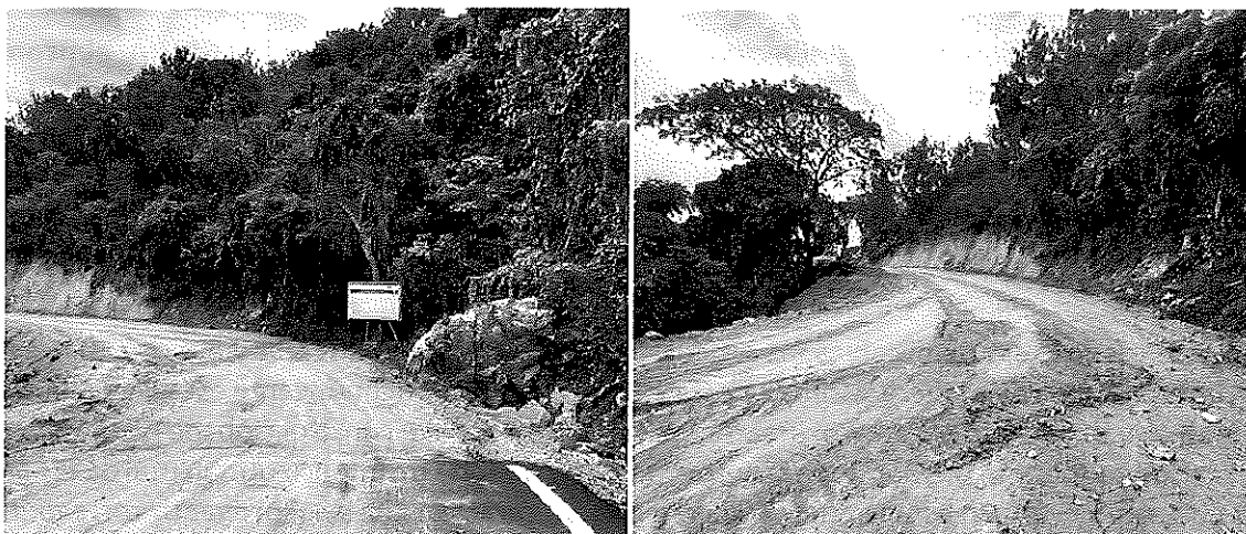
Ilustración 3. Inicio del subtramo a pavimentar (Km. 5+000)
