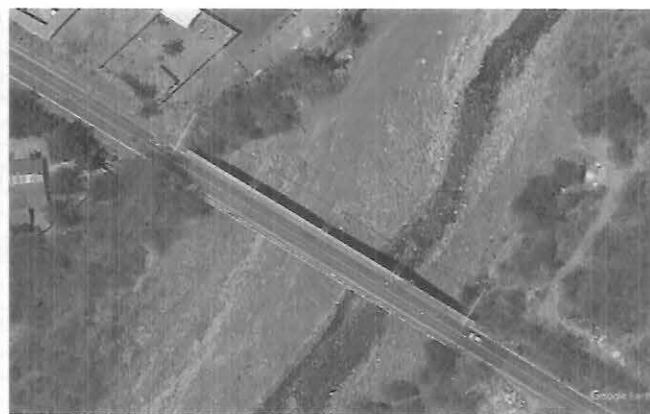
Imagen 2. Estructura del puente Armería, imagen proporcionada por el Promovente.
