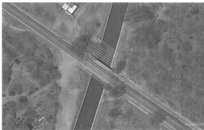
Imagen 1. Estructura del puente Canal Juárez, imagen proporcionada por el Promovente.
